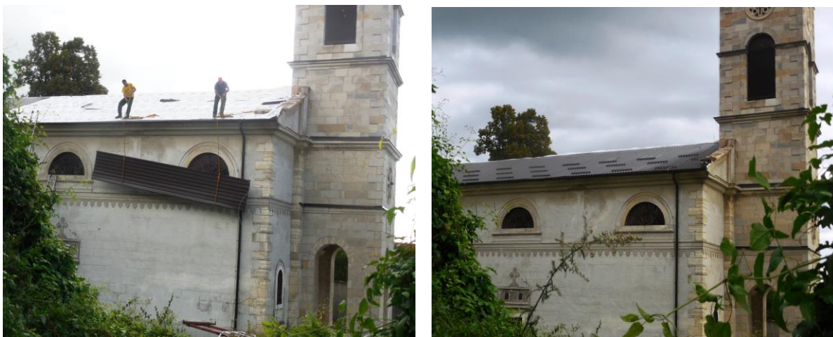
Радови на замени крова ливањске православне цркве
